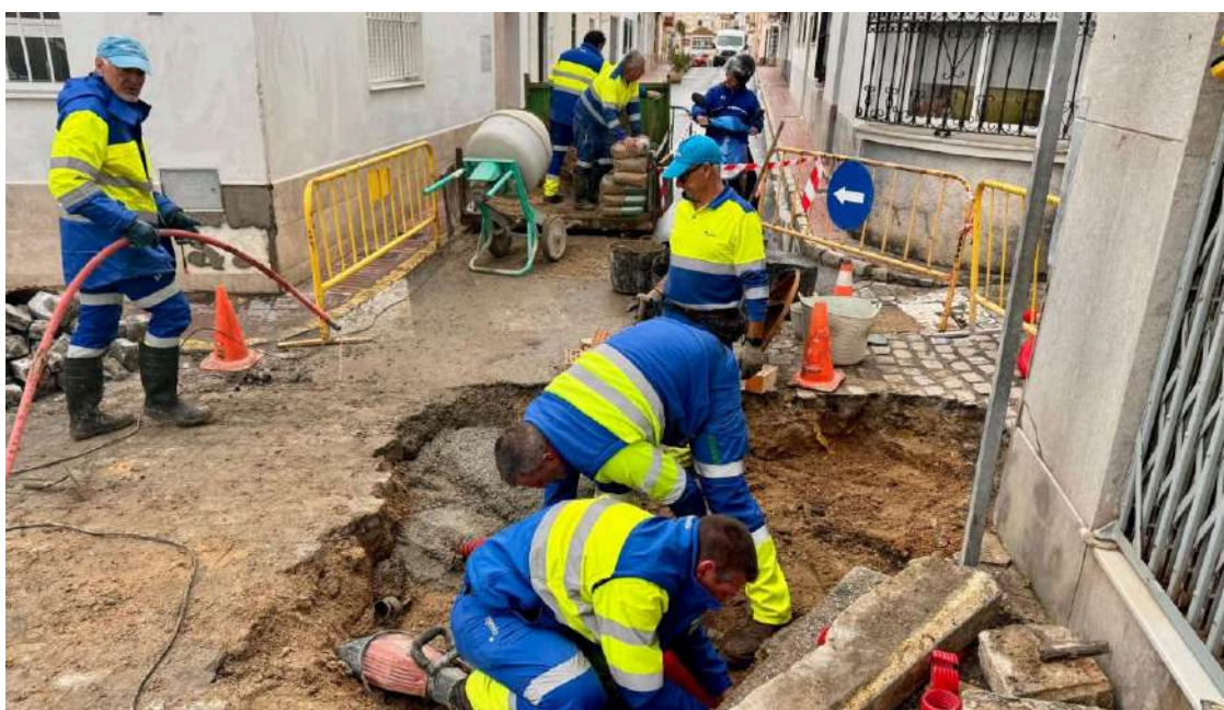
Así trabajan los operarios en la calle afectada en el centro.
