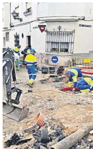
Trabajos en la calle San Cayetano.
