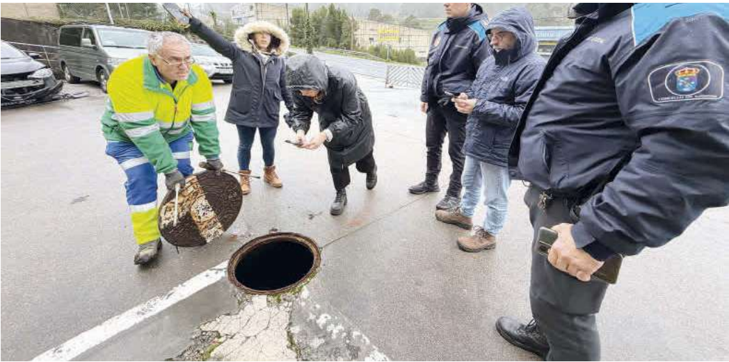
Operarios de la UTE, levantando alcantarillas del taller en presencia de personal del Concello, Xunta y Policía Local. | Santos Álvarez
