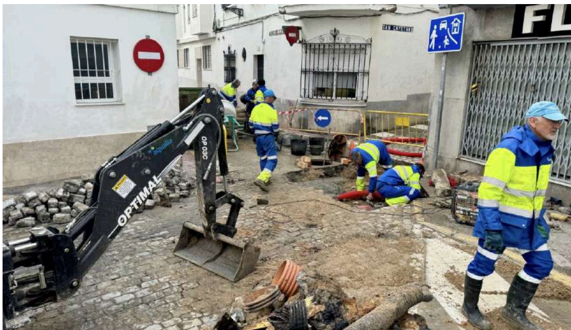
Los operarios trabajan tras el hundimiento registrado en la calle San Cayetano en Rota.
