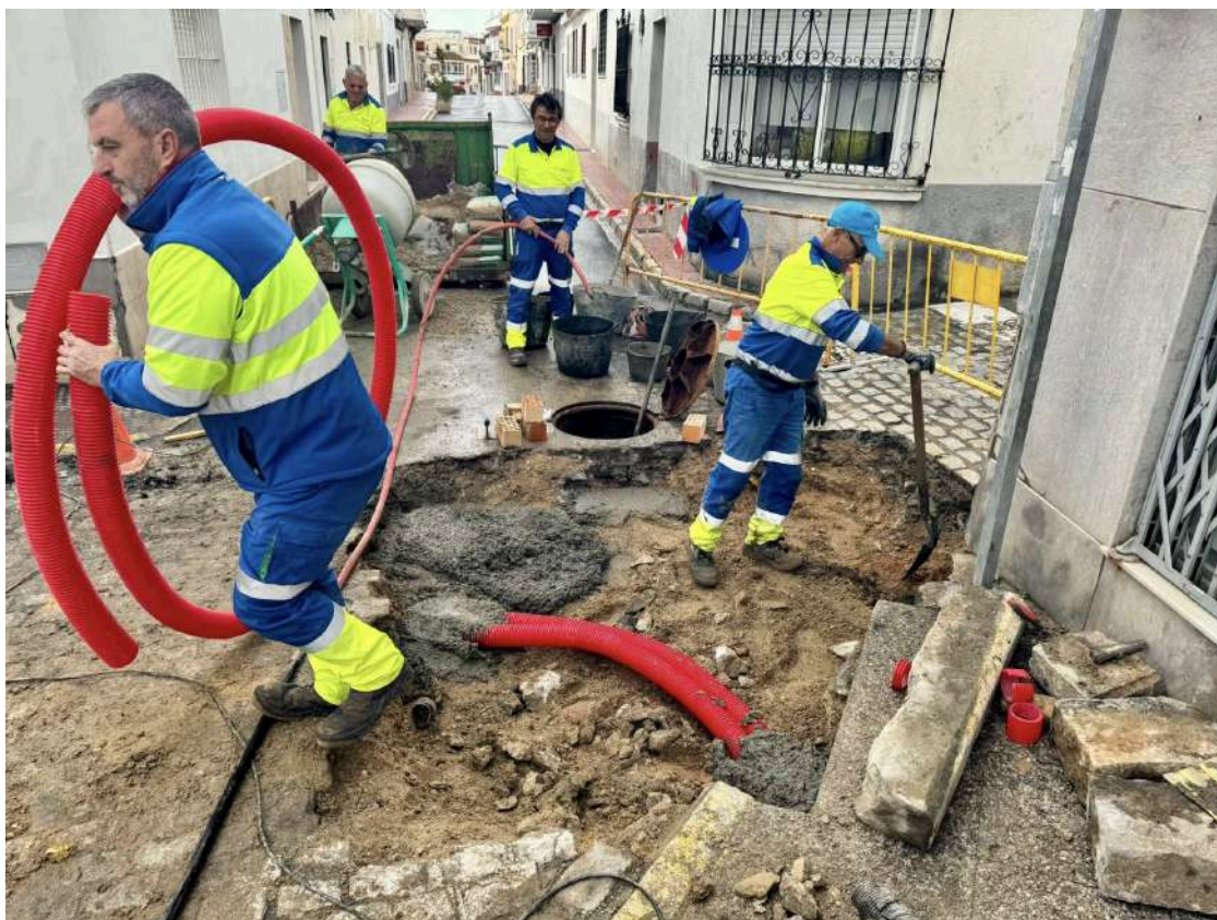
Trabajos en la calle San Cayetano en el centro de Rota.
